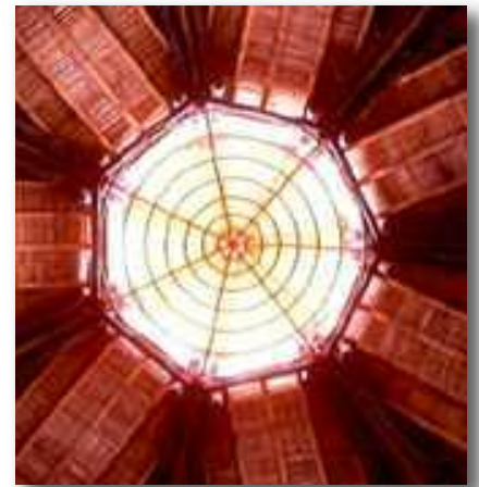
Roof of the Gran Salon.
